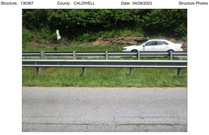
TYPICAL APPROACH GUARDRAIL POST SPACING
