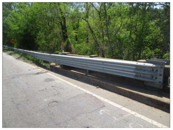
TYPICAL GUARDRAIL CONNECTION
